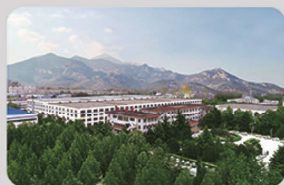
高端能源装备板块 山东泰山锅炉有限公司 BOILER WORKSHOP
