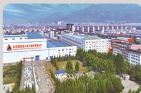
输变电装备板块 山东鲁能泰山电力设备公司 TRANSFORMER WORKSHOP
